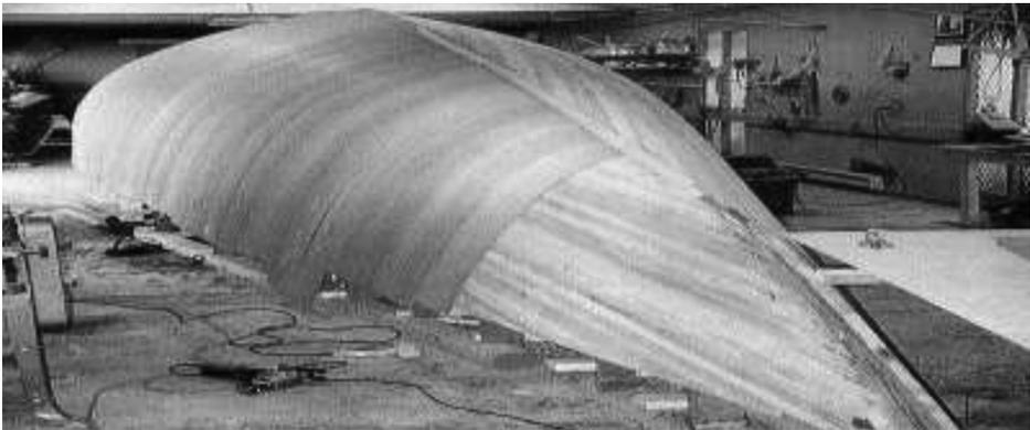
compuesta con epoxi, normalmente mediante gálibos con tiras de chapa, y atiesando finalmente el casco con palmejares y varengas, empleando en la zona de la quilla varengas de gran tamaño.
