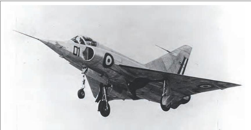
*El prototipo MD-550, en el que Jacques Alberto diseñó un nuevo carenado para la sección de cola del fuselaje.*
