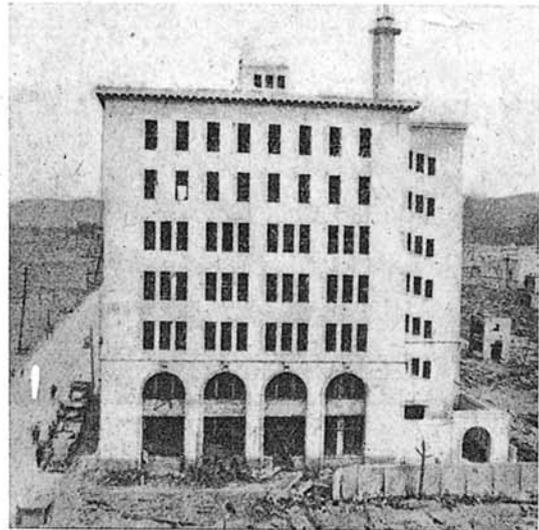
HIROSHIMA.—Alto edificio de la figura primera, visto desde el costado opuesto a la explosión, que tuvo lugar sobre la vertical del fondo y algo a la izquierda, a menos de 300 metros. La construcción, hecha de hormigón armado, estaba reforzada por una armadura de acero para defenderlo contra terremotos.
