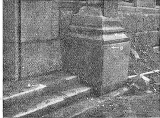
HIROSHIMA.—Los paramentos de granito de este edificio, a 200 metros solamente de la explosión, perdieron su pulimento por el efecto calorífico. Se exceptúan solamente la sombra de un hombre sentado en A, del que incluso aparece la pierna izquierda apoyada en el primer escalón; la de otro, B, que de pie se apoyaba en el canto de la columna. La misma moldura de la columna ha dejado impresa en C su sombra.
