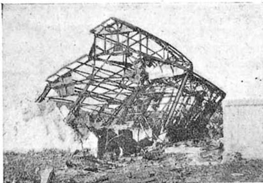
HIROSHIMA.—Destrozos en la estructura de un pequeño taller situado a unos 400 metros de la explosión.
