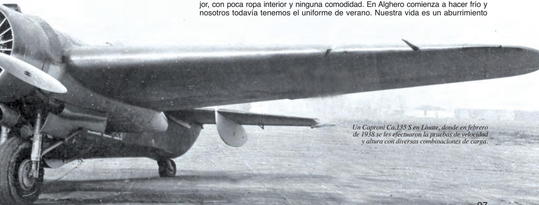
*Un Caproni Ca.135 S en Linate, donde en febrero de 1938 se les efectuaron la pruebas de velocidad y altura con diversas combinaciones de carga.*
