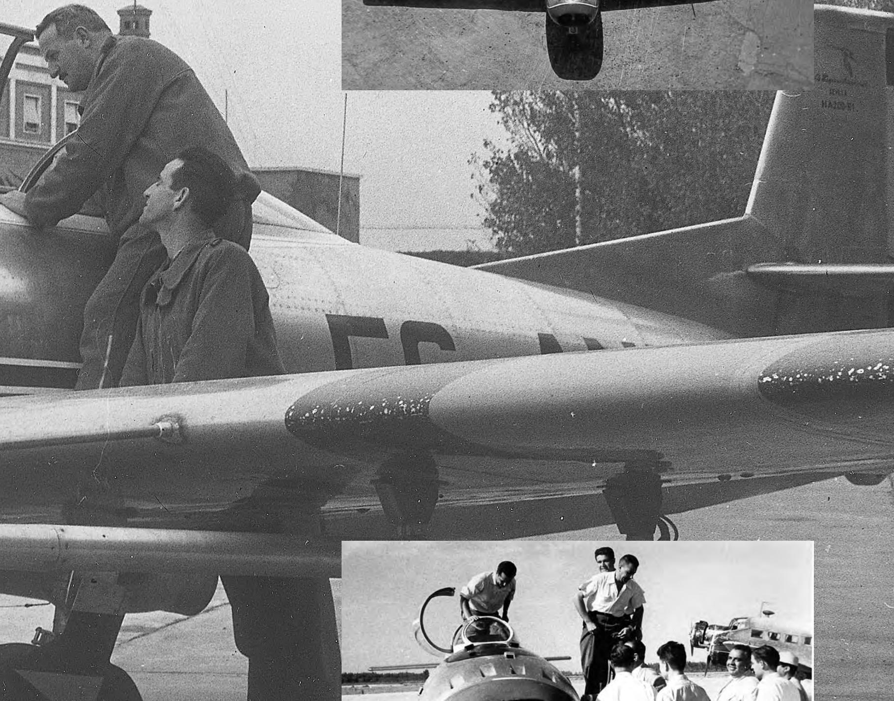
Tras un primer vuelo, Esteva y Valiente descienden del 20/1, en el que pueden contarse hasta once tomas de aire visibles, incluida una en el borde de ataque del encastre alar, mientras el director de la fábrica y otro de los ingenieros tocan, con cierto disimulo, el capó para comprobar la temperatura. Es el día 12 de agosto. (Foto: archivo del autor).
