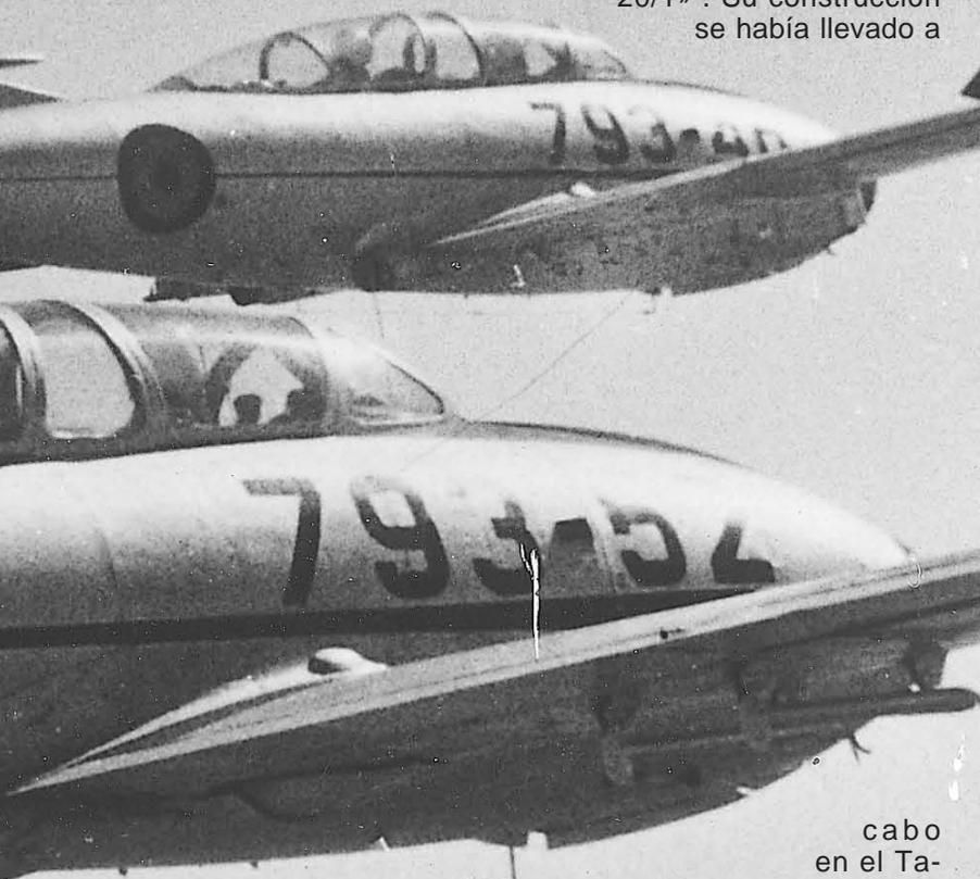
cabó en el Taller de Prototipos de La Hispano Aviación S.A., en la trianera calle de San Jacinto, entre el verano de 1954 y el del año siguiente. Se trataba, como todo el mundo sabe ya, del avión «Serie HA 200», destinado a la enseñanza y con dos reactores Turbomeca Marboré II en el fuselaje<sup>3</sup>. Fernando de Juan Valiente, en su calidad de piloto de pruebas de la firma, se encargó de efectuar el primer vuelo del ya bautizado como «Saeta»: era el 12 de agosto de 1955. Y aquí se produce el
