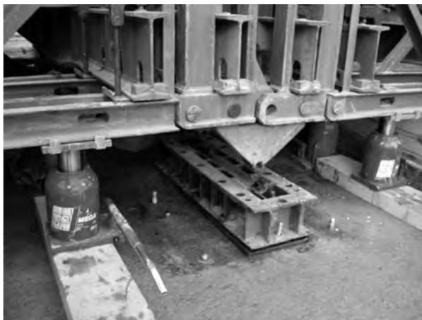
Foto nº 6. Maniobra de gatos para sustituir un cojinete dañado.
