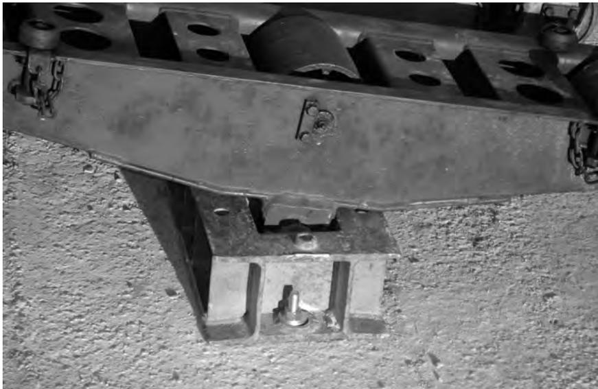
*Foto nº 3. Sujeción del cojinete al hormigón.*
