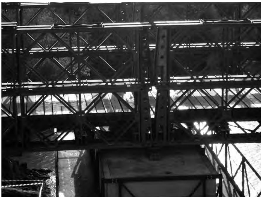
Foto nº 7. Aspecto final de la unión de los tramos sobre la pila 1.
