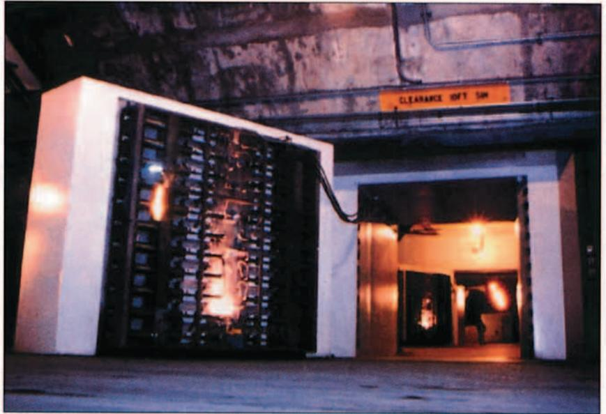
*En caso de un ataque, el Complejo quedaría completamente aislado del exterior mediante un conjunto de puertas antinucleares dobles de más de un metro de espesor.*
